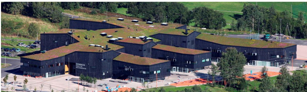
Rommen skole har sedumtak, og fasaden er malmfuru; en bestandig tresort.
