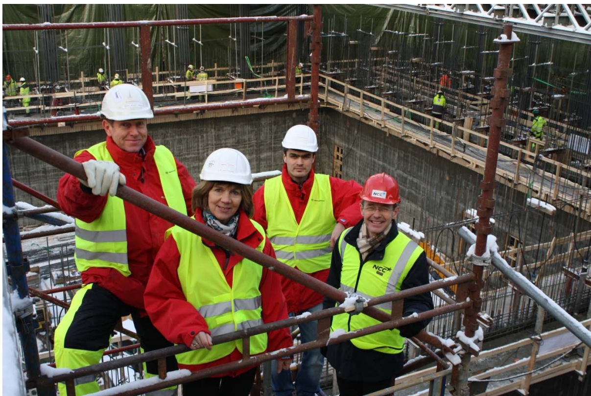
Støping av idrettshall på Frydenberg skole.
